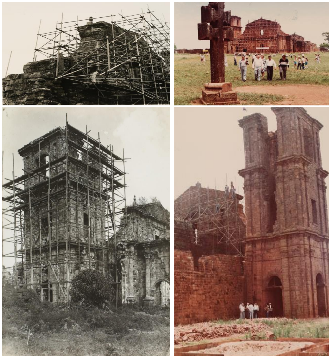
Figuras 3A, 3B, 3C e 3D: Recuperação das Ruínas da Igreja de São Miguel Arcanjo
