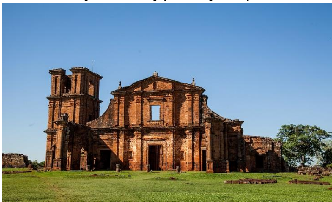
Figura 5 - Ruínas da Igreja de São Miguel Arcanjo
