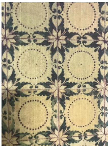
Figura 13: Casa Azulejo Português, detalhes do revestimento.
