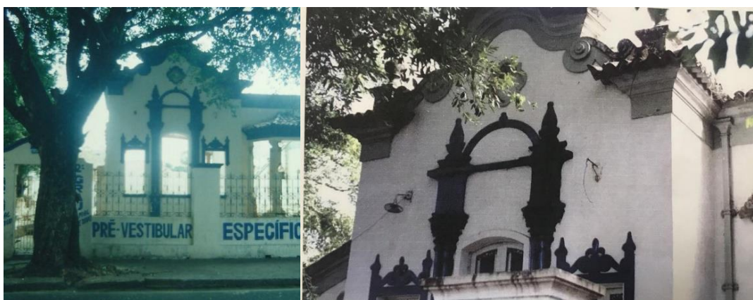
Figuras 02 e 03: Colégio Prismático antes da demolição.
