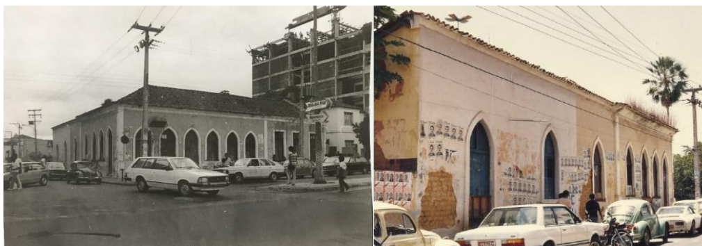
Figuras 06 e 07: Casa Antonino Freire, antes da demolição.
