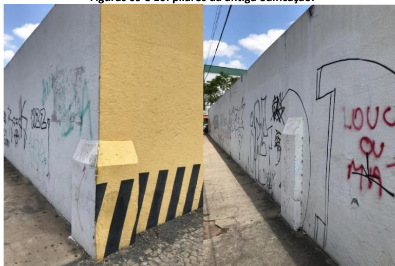
Figuras 09 e 10: pilares da antiga edificação.
