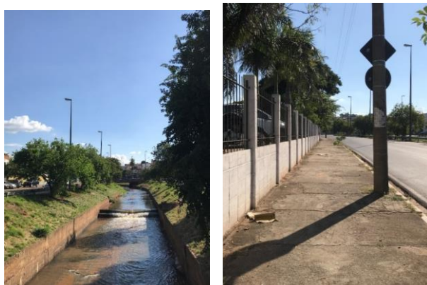
Figura 5 – Árvores existentes e a falta de sombra
