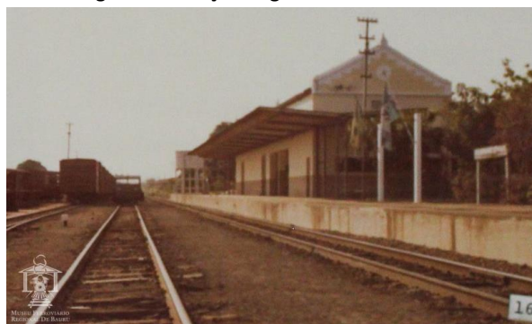
Figura 1 – Estação Miguel Calmon em 1982.
