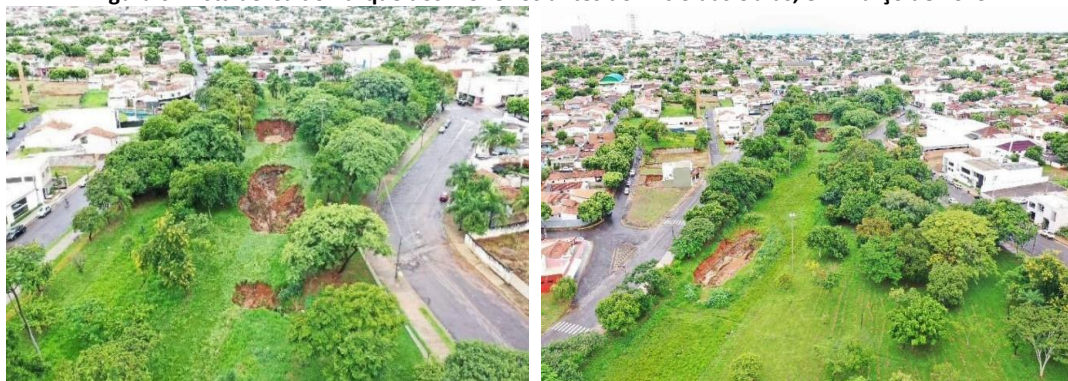
Figura 6: Vista aérea do Parque dos Pioneiros antes do início das obras, em março de 2019.
