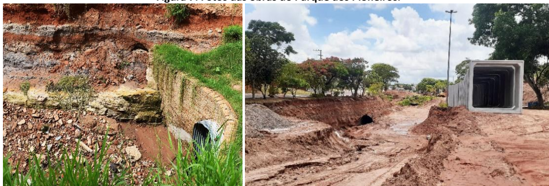
Figura 7: Fotos das obras do Parque dos Pioneiros.
