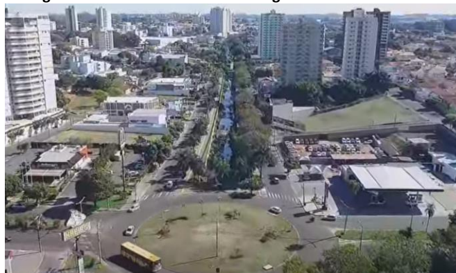
Figura 8: Final do Trecho D – Córrego canalizado aberto
