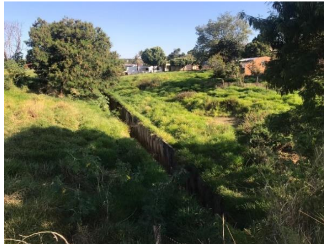
Figura 11: Foto da área de margem do córrego canalizado vista da Rua Niterói
