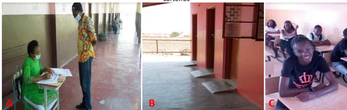
Figura 6 - A) Tipo de piso corredores. B) Rampas de acesso as salas de aulas. C) Salas de aulas e tipologia das carteiras
