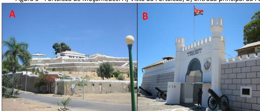
Figura 5 - Fortaleza de Moçâmedes. A) Vista da Fortaleza; B) Entrada principal da Fortaleza.
