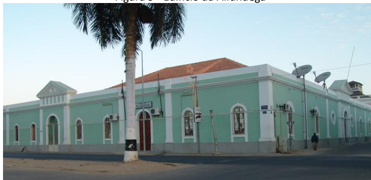
Figura 9 - Edifício da Alfândega
