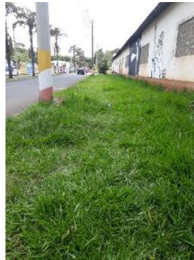
Figura 8 – Ausência de calçada na quadra F2.
