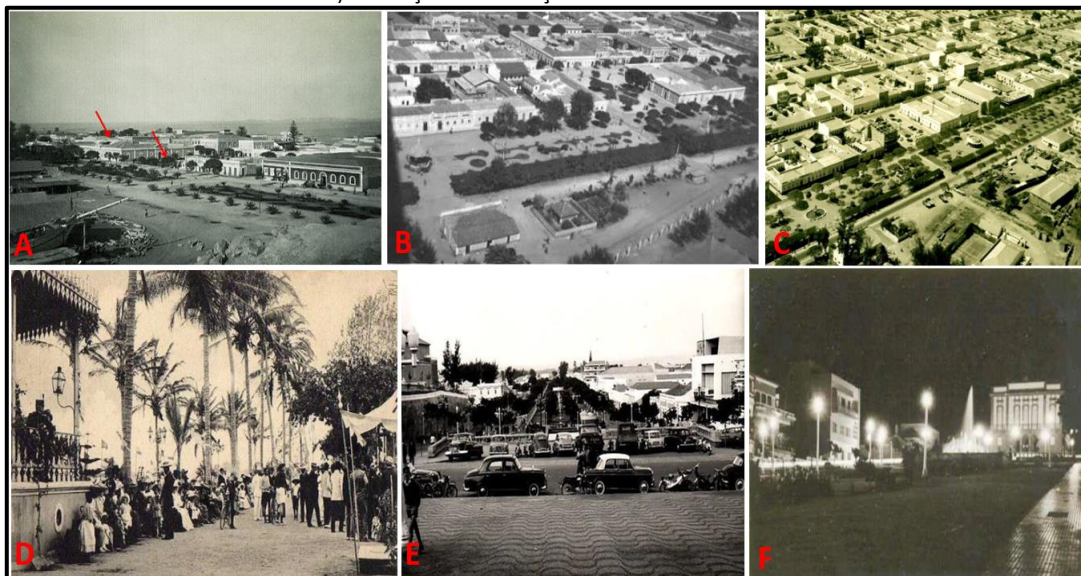
Figura 2 - Aspeto arquitetônico e funcional da avenida no período colonial: A) Implementação do jardim no início do século XX. B) Jardinagem e arborização (retrato de 1945). C) forma quadrangular da avenida. Aspecto funcional: D) Um trecho da avenida em dia de festa E) Zona sul da avenida, estacionamento público. F) Animação e iluminação noturna década 60.
