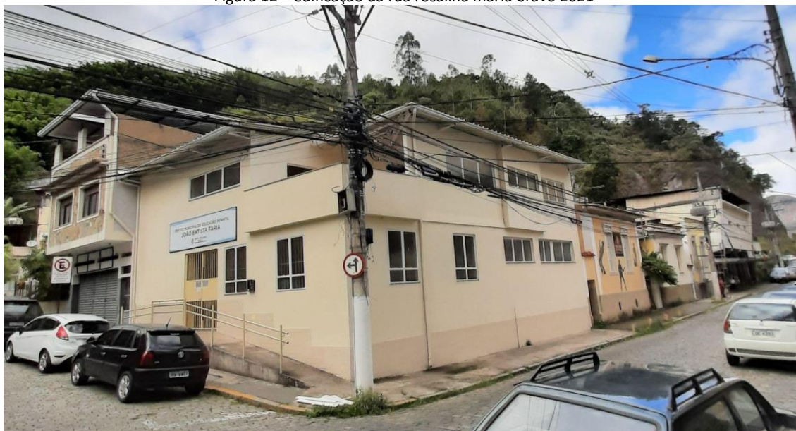
Figura 12 – edificação da rua rosalina maria bravo 2021
