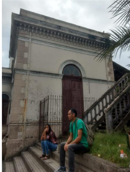
Figura 06: área com gradil ao lado da passarela.
