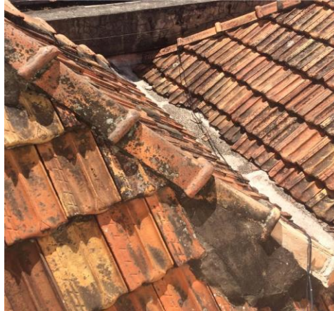
Figura 12: Detalhes da cobertura, vista pela torre.
