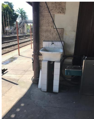
Figura 05: Área externa posterior/norte com um pequeno trecho da parte empoçada.
