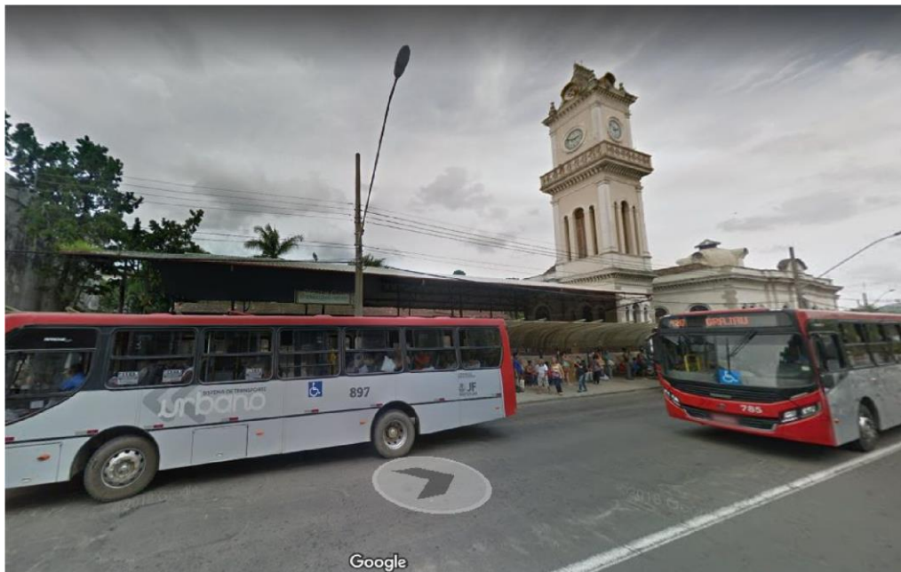
Figura 02: Fachada principal com a localização do ponto de ônibus.
