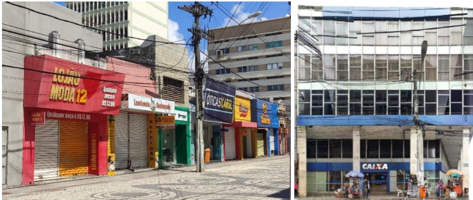
Figura 9 (esquerda) – Publicidade empregada em edifícios comerciais. Figura 10 (direita) – Publicidade empregada em edifício institucional.
