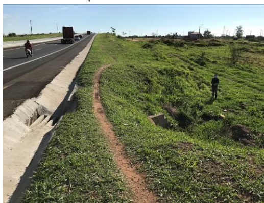
Figura 6 – Localização de tubulação de drenagem próxima a rodovia.
