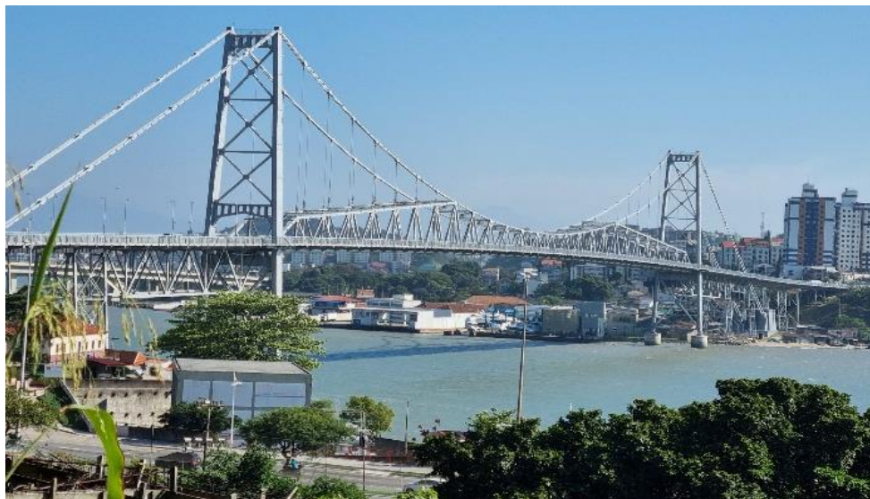
Figura 2 – Vista ponte Hercílio Luz
