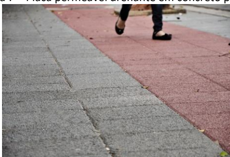
Figura 7 – Placa permeável drenante em concreto poroso.
