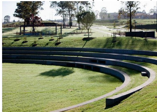
Figura 12 – Anfiteatro bacia de detenção, Parque Redfern, Sydney.
