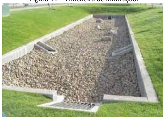
Figura 11 – Trincheira de infiltração.
