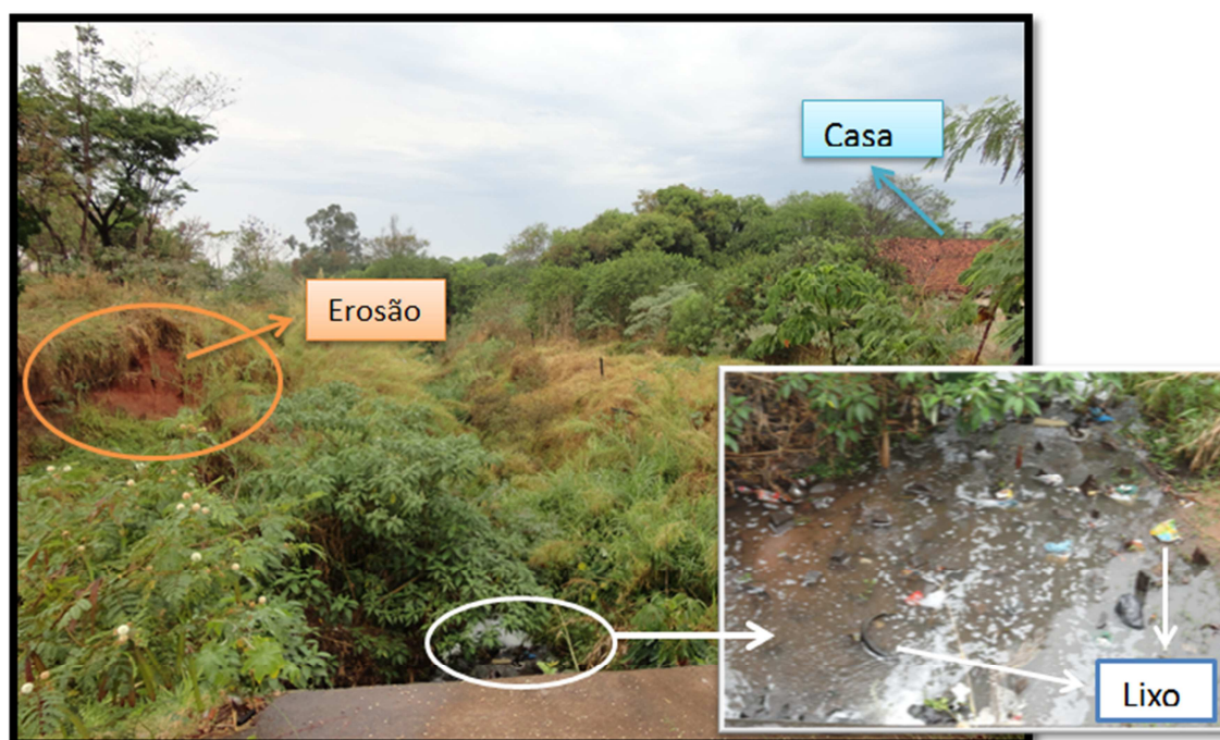
Figura 4: Córrego do Jaboticabal, Ponte da Av. Jacomo Bertoli. Acervo pessoal, 2012.
