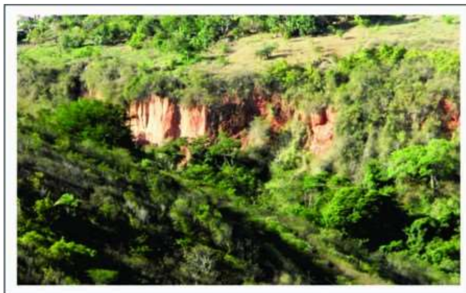
Figura 08 - Desmoronamento de encosta de vale.
