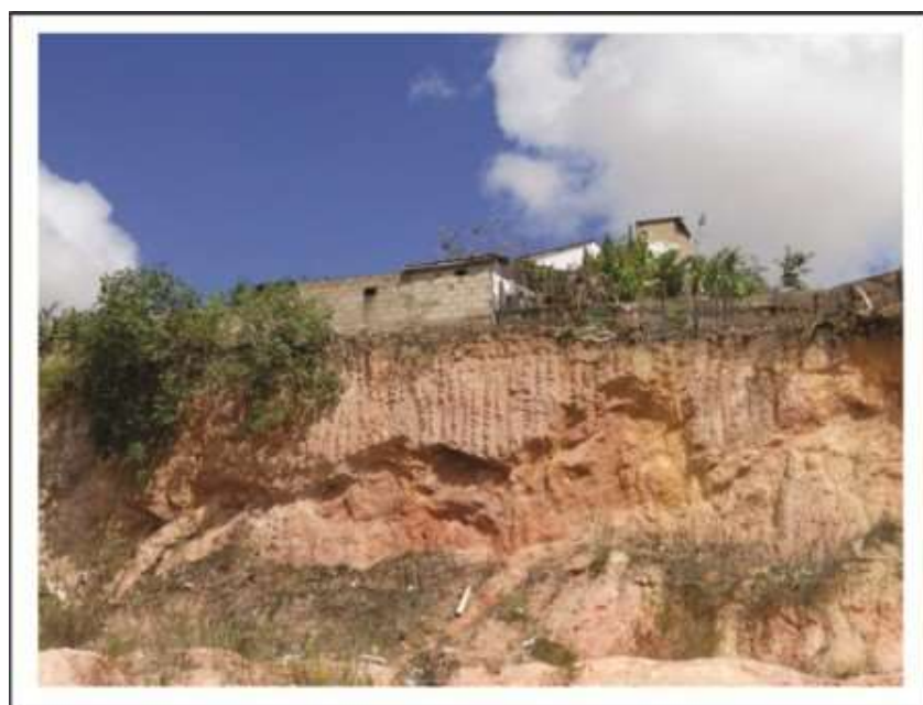
Figura 10 - Desmoronamento em área residencial.
