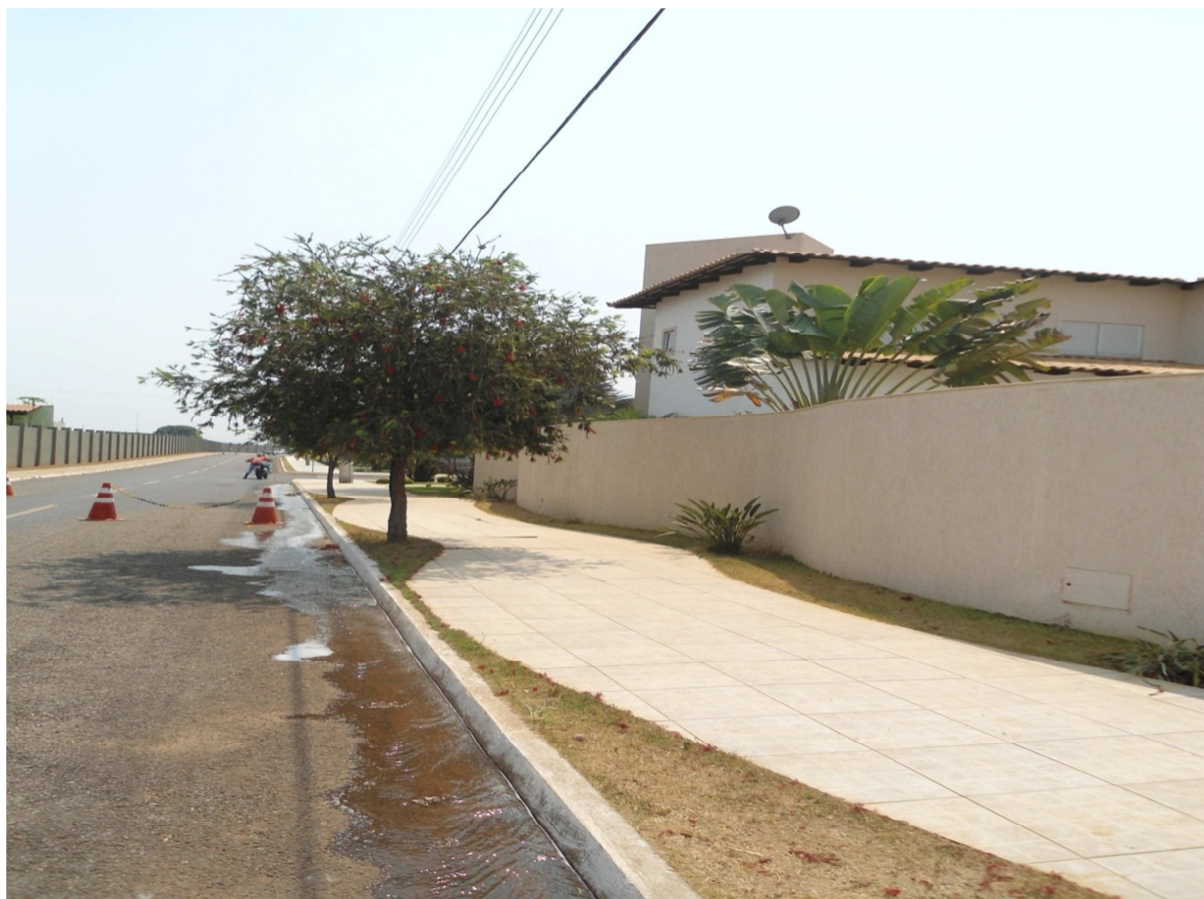
Figura 9. Calçada ecológica com piso intertravado (paver) em condomínio da cidade de Anápolis, Goiás com a utilização da espécie calistemo.
