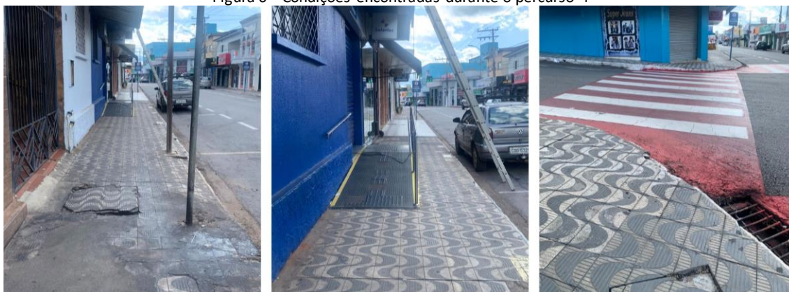
Figura 6 – Condições encontradas durante o percurso 4
