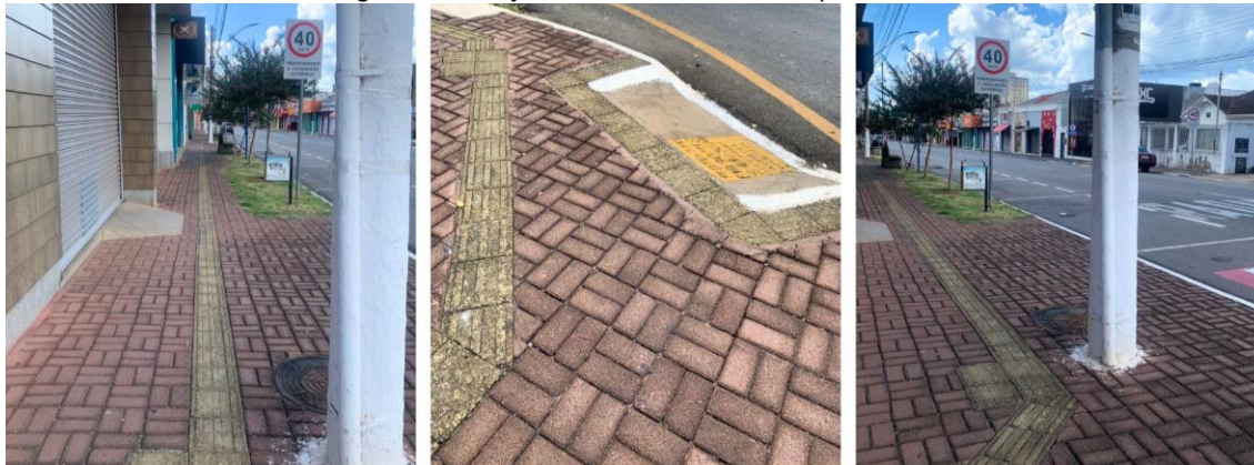
Figura 3 – Condições encontradas durante o percurso 1
