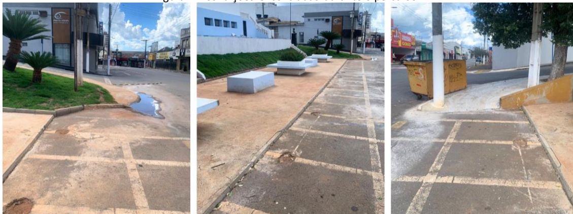
Figura 4 – Condições encontradas durante o percurso 2
