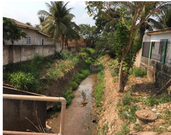
Figura 10- Córrego Central canalizado no trecho que corta a quadra 60 no Centro
