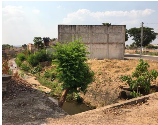
Figura 9- Córrego Central canalizado no trecho que corta a quadra 55 no Centro
