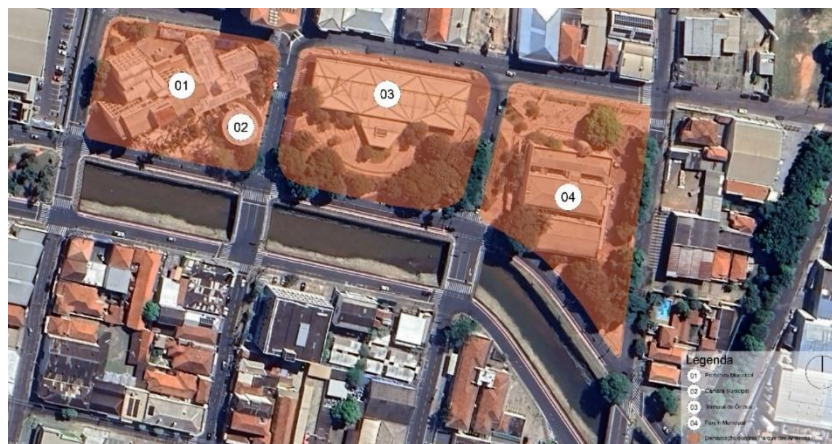
Figura 7 – Imagem aérea mostrando os novos edifícios implantados no parque: Prefeitura, Câmara, Terminal Urbano e Fórum
