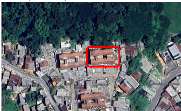
Figura 1 – Imagem aérea do Bloco 89 no Curado
