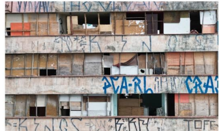
d) Detalhe retirado da fachada sul, mostra a instalação de tapumes em grande quantidade no edifício.
