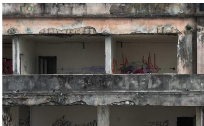
c) Detalhe retirado da fachada sul, mostra a retirada das esquadrias em grande quantidade por todo o edifício.
