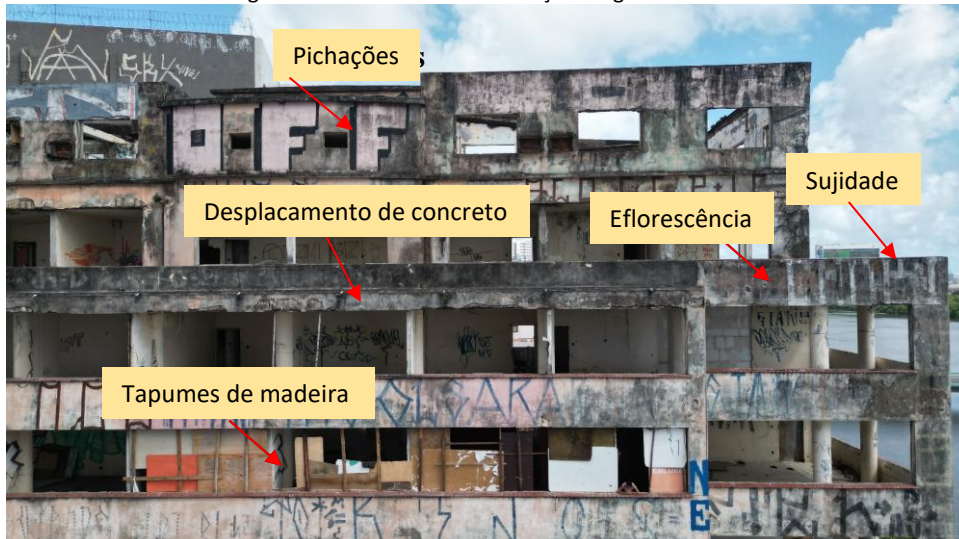
Figura 5 - Fachada Sul da Edificação Sergadas Vianna
