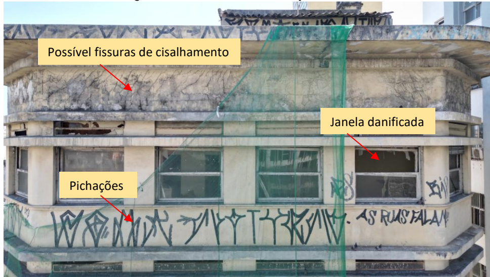
Figura 4 - Fachada Oeste da Edificação Sulamérica
