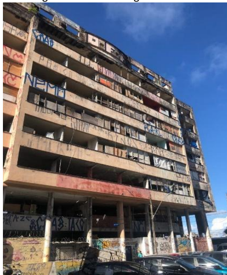
Figura 2 - Edifício Segadas Vianna.
