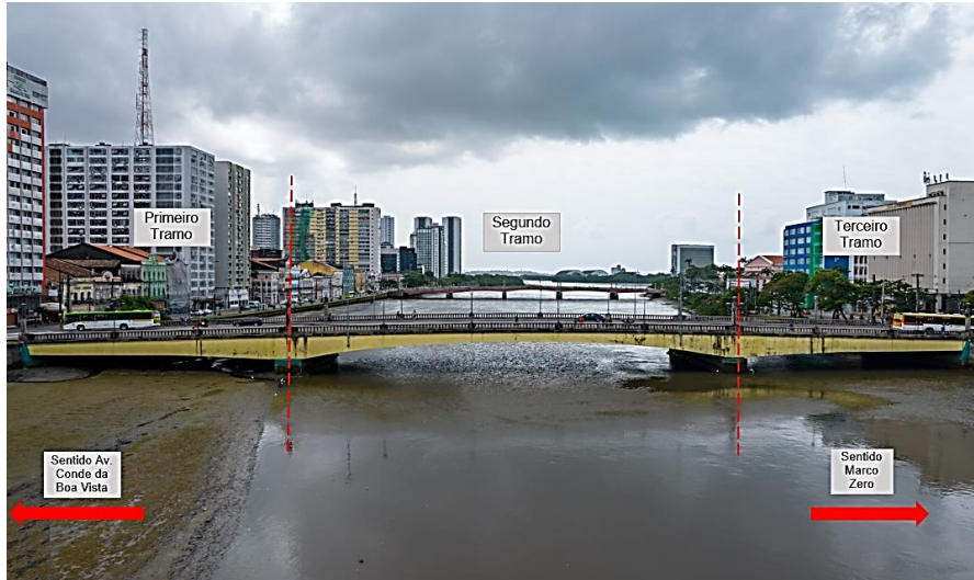
Figura 7 – Vista lateral e panorâmica da Ponte Duarte Coelho, com as divisões.
