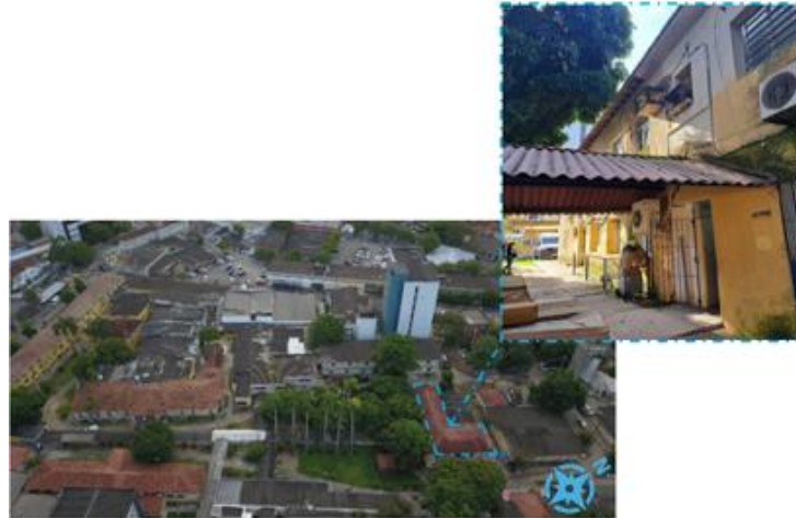
Figura 3 - Posicionamento no HUOC e vista da fachada principal do objeto de estudo
