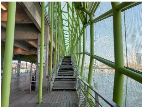
Figura 16 - Cité , acesso vertical
