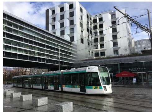
Figura 19 - Rasgo na estrutura, linha VLT
