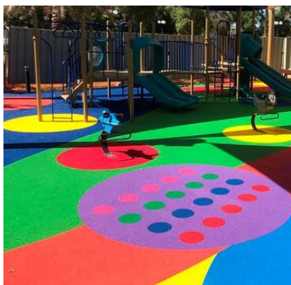
Figura 10 - Referência do piso de borracha monolítico drenante
