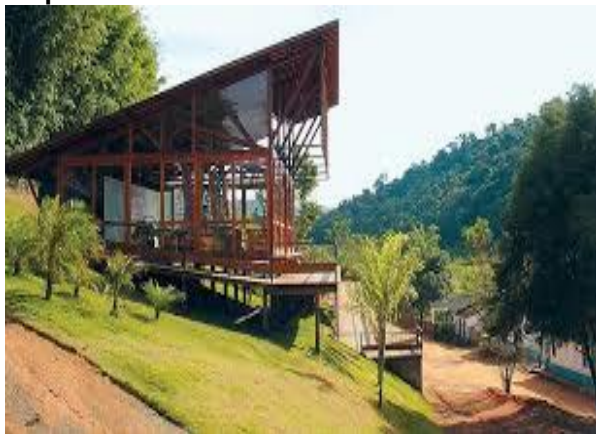
Figura 05: Planos de Vidro - centro educacional e cultural, Poços de Caldas, MG. Arquiteto: Alfredo Barbosa Jr.
