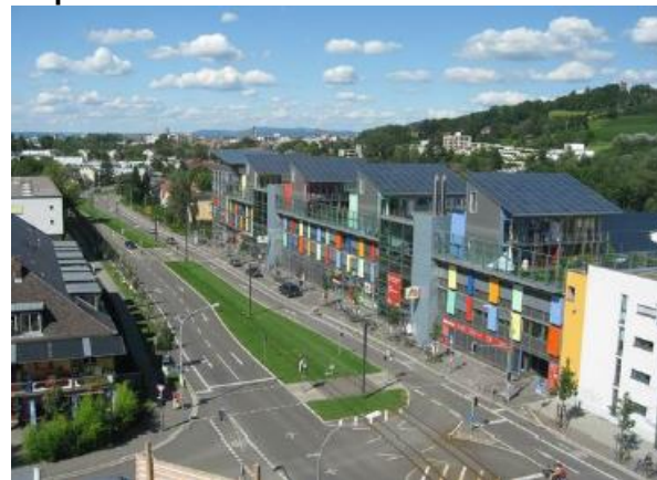
Figura 06: Vista do bairro Vauban, coberturas com painéis solares, Friburgo - Alemanha. Arquiteto: Rolf Disch.
