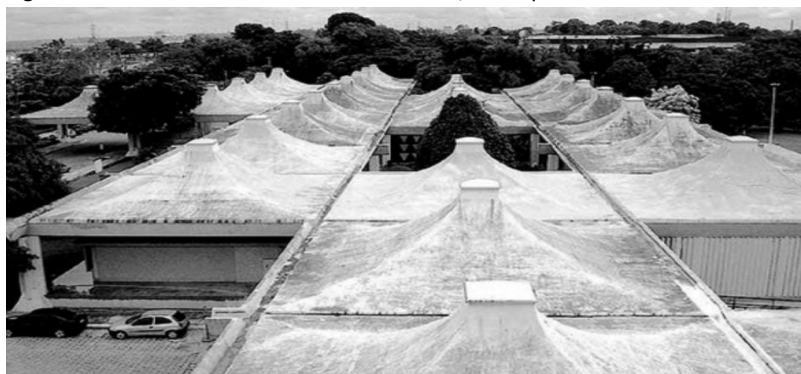
Figura 01: SUFRAMA-AM – Cobertura em coifa/domo parte externa
