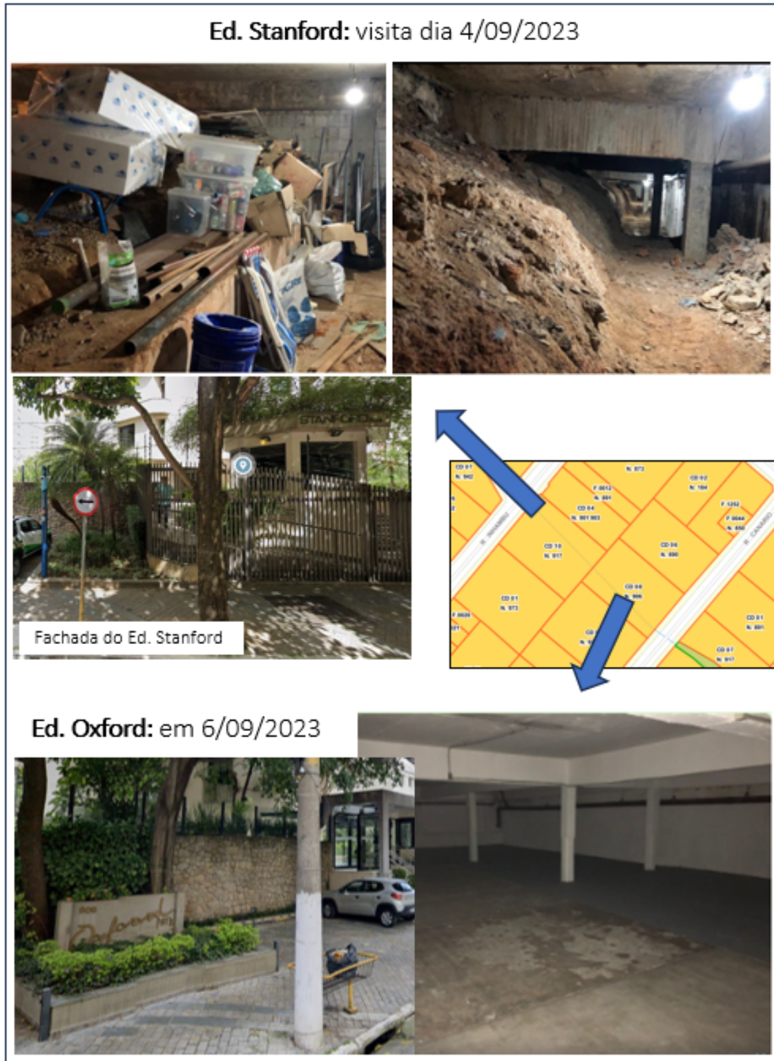
Figura 8 – Subsolos dos prédios na faixa não edificante na quadra Canário – Inhambu em meados de 2023
