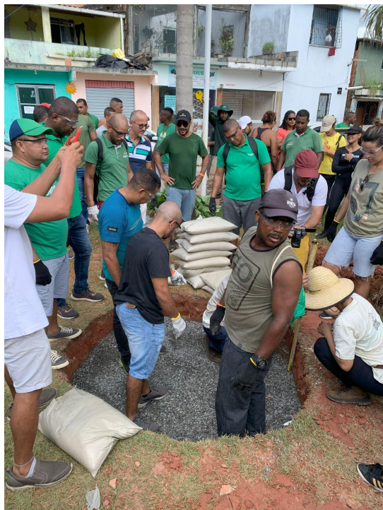
Figura 9 – Diferentes momentos do processo de implantação de um jardim de chuva na Praça de Saramandaia.
