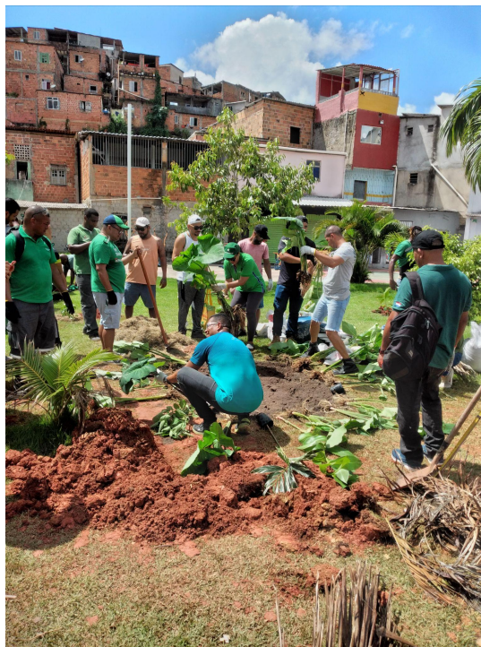
Figura 9 – Diferentes momentos do processo de implantação de um jardim de chuva na Praça de Saramandaia.
