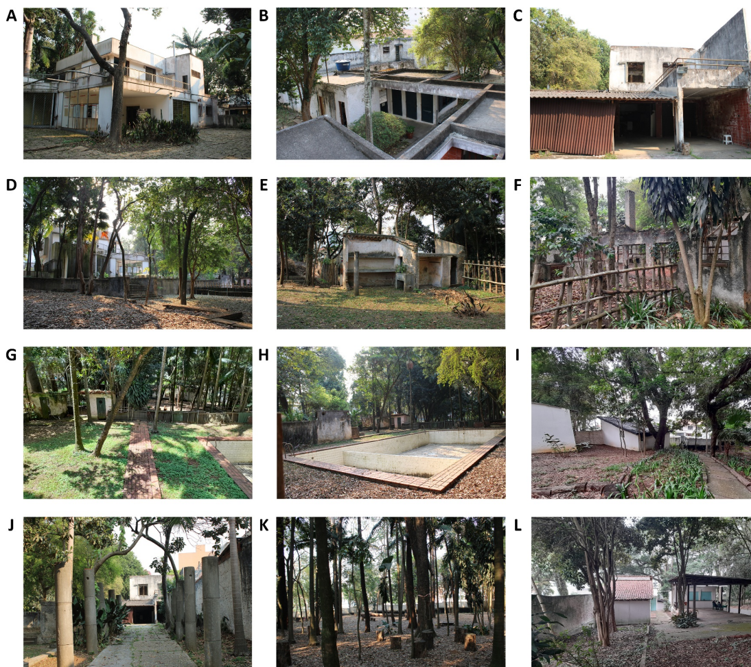
Figuras 15: Levantamento fotográfico – Estado atual dos equipamentos (2023-2024)
