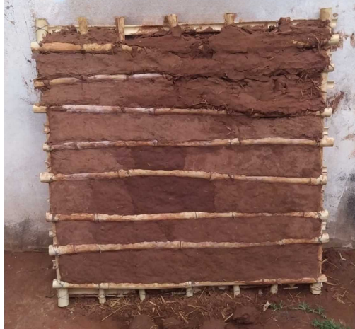
Figura 3 – Resultado final após secagem da taipa de mão
