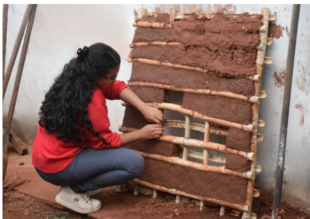
Figura 2 – Aplicação manual da massa na estrutura
