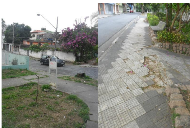
Figuras 7A e 7B – Lixeira vandalizada e Rachaduras no Piso, ambos da Praça Antônio Santarelli, Vila Jaguaribe, Osasco, SP.
