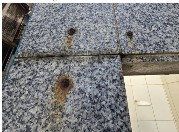
Figura 3 – Parafusos oxidados.
