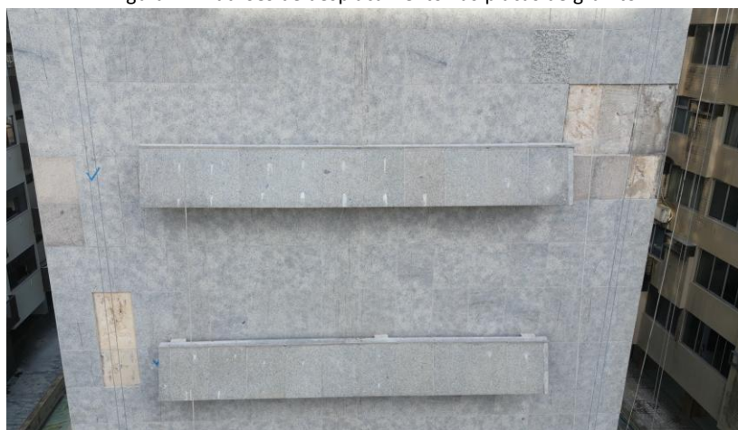
Figura 4 – Padrões de deslocamento nas placas de granito.
