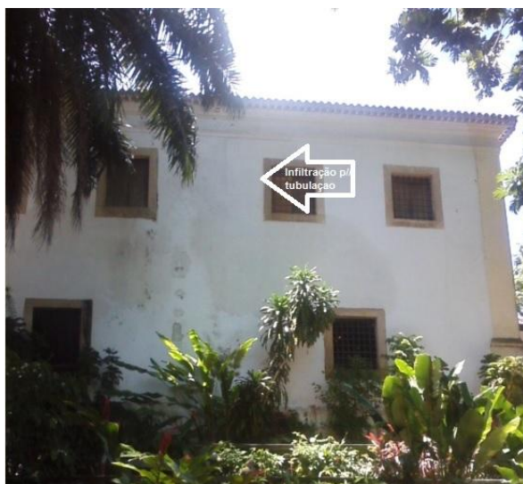
Figura 6- Região de infiltração na parede posterior por águas de chuva pela tubulação
