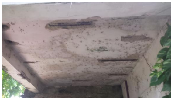
Figura 7 – Vista da laje de piso do terraço com manifestação patologia característica de oxidação das armaduras
