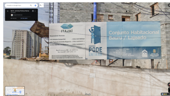
Figura 7 – Placa de construção para o terreno a montante da Nascente 7.
