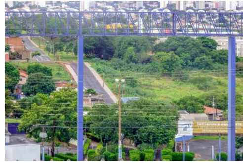
Figura 4: Imensa área de cabeceira de drenagem ocupada indevidamente
