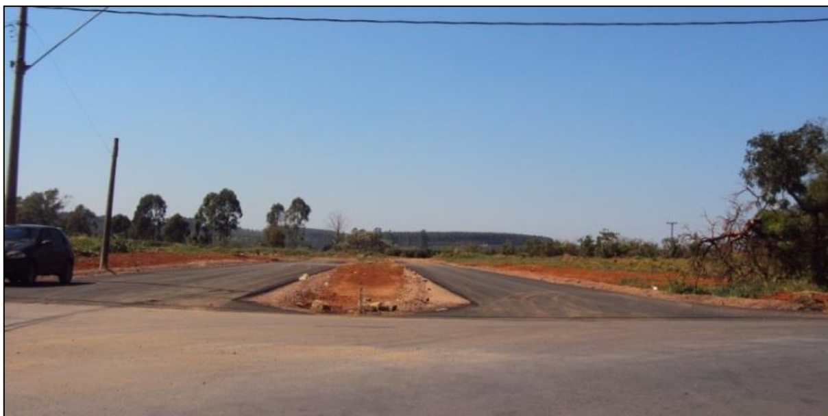
Foto 2: Alto curso da bacia do rio Dourados: Abertura de novos setores do Bairro Nações
