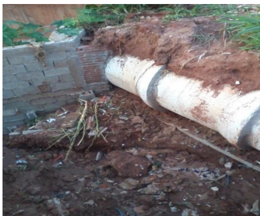
Figura 8 – Manilha lançando água na cabeceira do Córrego Buritizal
