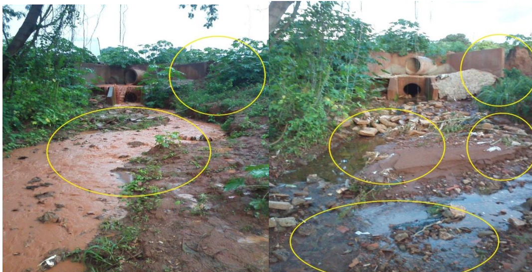
Figura 5: Galerias de águas pluviais 12/11/2014 e 01/12/2014.
