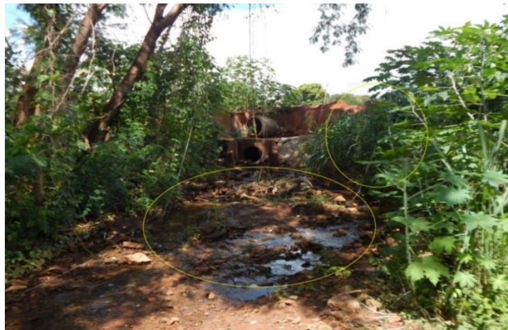
Figura 6: Galerias de águas pluviais 28/01/2015
