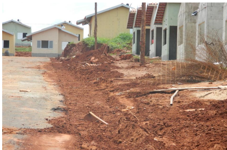
Figura 05: Construção de arruamentos.
