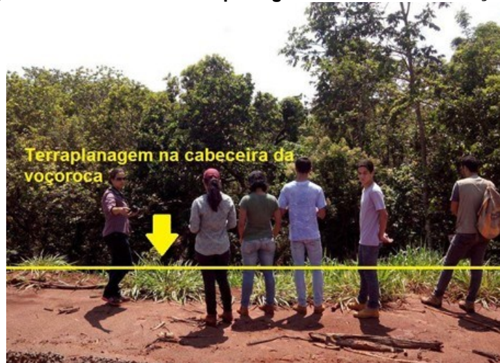
Figura 11: Processo de terraplanagem na cabeceira da voçoroca
