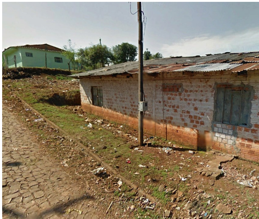
Figura 02: Detalhe dos alinhamentos prediais no bairro São João.
