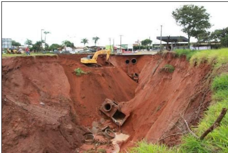
Figura 06 – Erosão remontante desencadeada na boçoroca em junho de 2015
