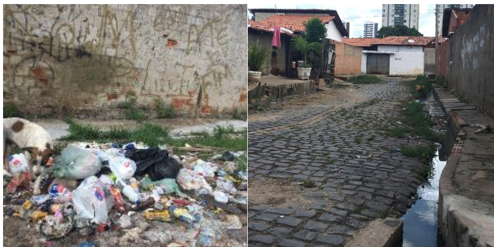
Figura 10 e 11 – Despejo de lixo e condições das vias que inundam durante as chuvas fortes.
