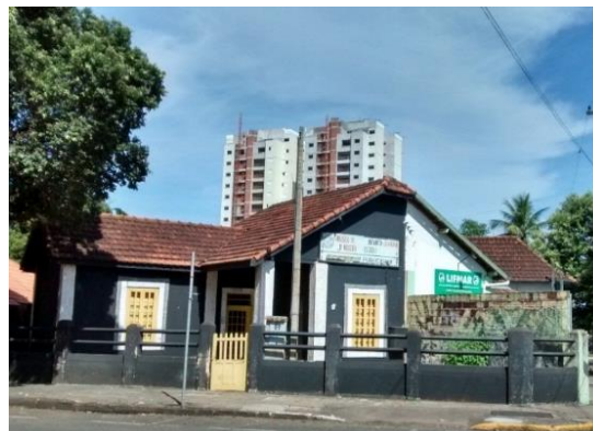
Figura 3 – Imóvel antiga Vila dos Ferroviários, 2017.
