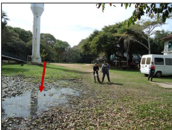
Foto 5: Área rebaixada alagada
