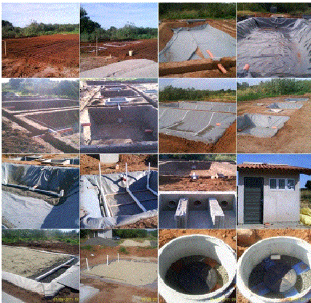
Figura 3. Etapas de construção da ETE.
