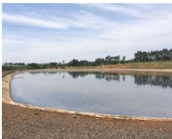
Figura 9: Lagoa anaeróbia da ETE Polidoro
