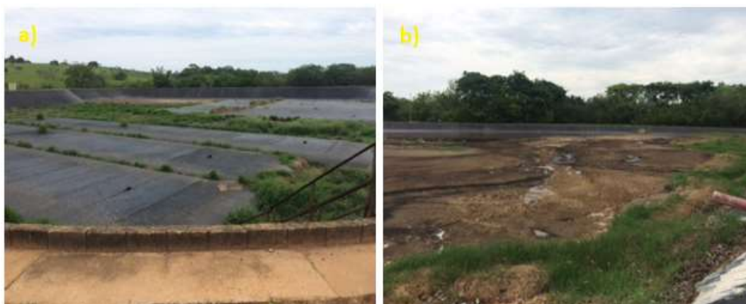
Figura 17: Aterro sanitário para descarte de lodo (a) em bags (b) e misturado com cal
