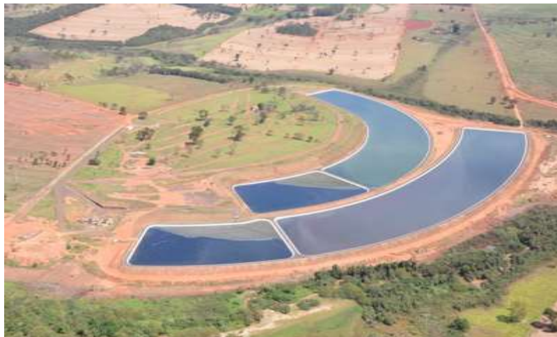
Figura 6: Imagem aérea da ETE “Antônio Aparecido Polidoro”
